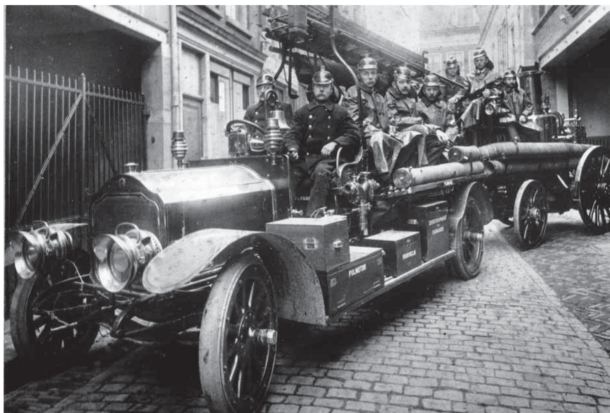
De tweede auto-spuit, eveneens een Lorraine-Dietrich/Drouville – in dienst sinds 1910 – uitrukkend met aangekoppelde stoomspuit vanuit de garage aan de Annastraat.
