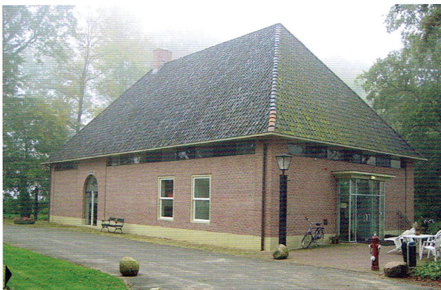
Voor het Internationaal Brandweermuseum in Rijssen werd zelfs een eigen gebouw opgericht in de oude lokale stijl, dat wel. Foto: Gerard Koppers
